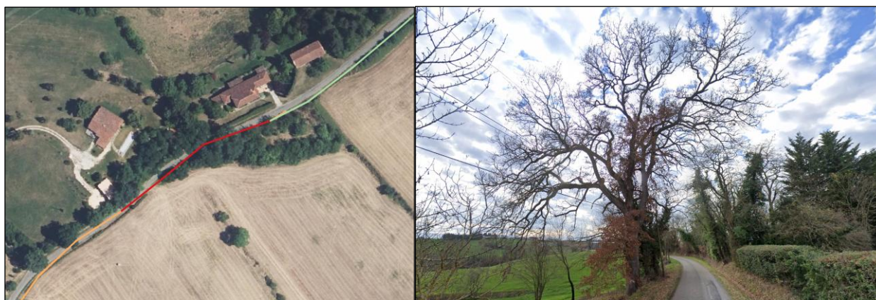
Figure 15 : Exemple de câble aérien 24 fibres desservant plus de 150 locaux passant sous un arbre isolé.
